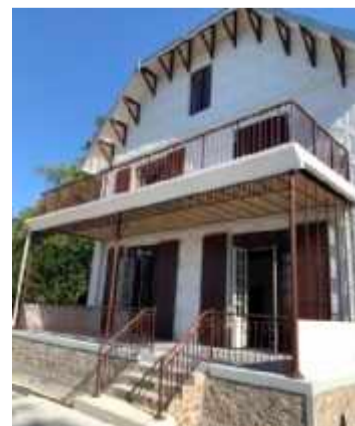
La maison de fer de Poissy a été restaurée par MétalNéo. JEAN-FRANÇOIS PAILLER
